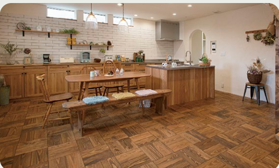
パケット張り
